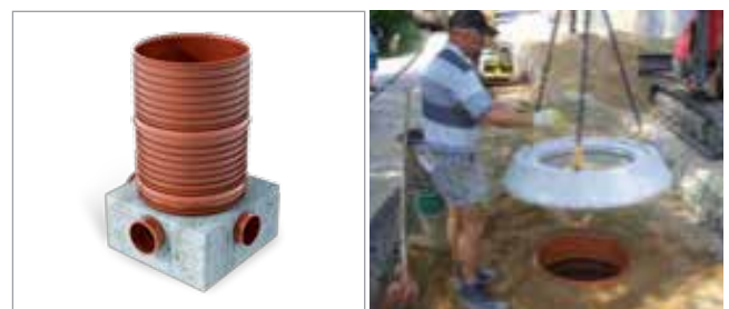
Obetonování Obr. 19 Osazení prstence Obr. 20
