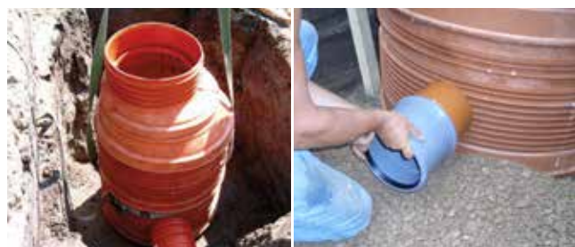
Šachta ve výkopu Obr. 15 Flexibilní hrdlo Obr. 16
